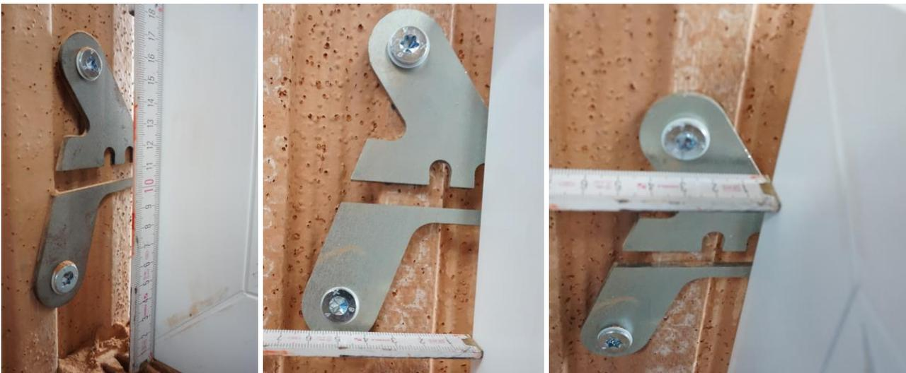
**Bild 12** Detail Fenstersicherung und Angabe der Schraubenabstände (Element 1)
