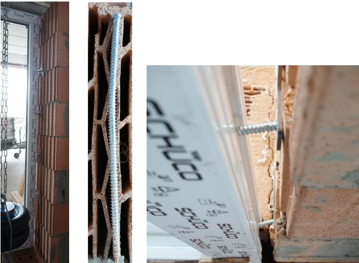
**Bild 14** Anzahl der Befestigungspunkte (links); plastische Verformung der Schraube (rechts)
