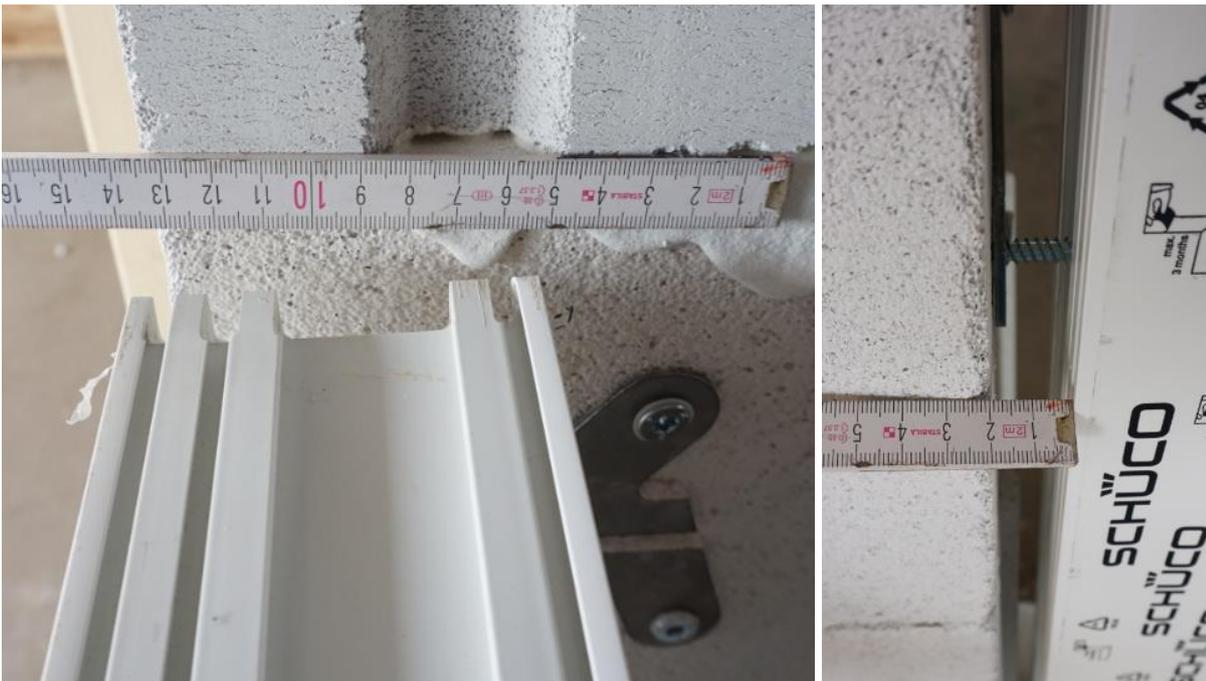
**Bild 16** Abstände Fenstersicherungs- und Mauerwerkswand
